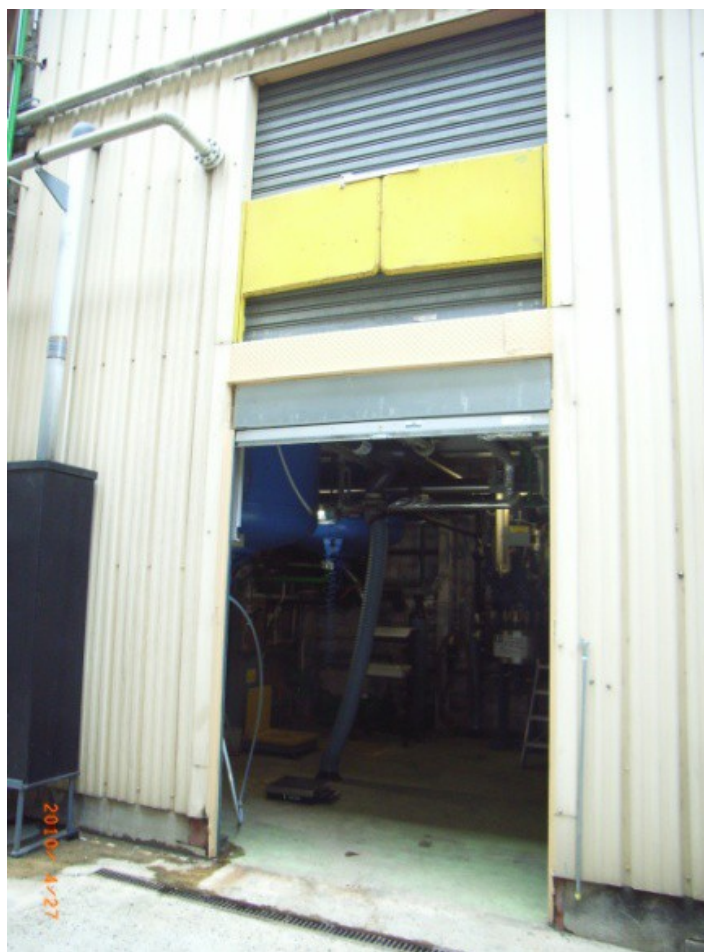
Photo 25 - Extérieur du local d'hydrogénation
