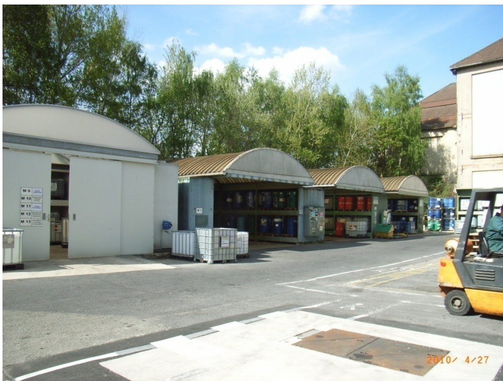
Photo 1 : vue des stockages extérieurs.
