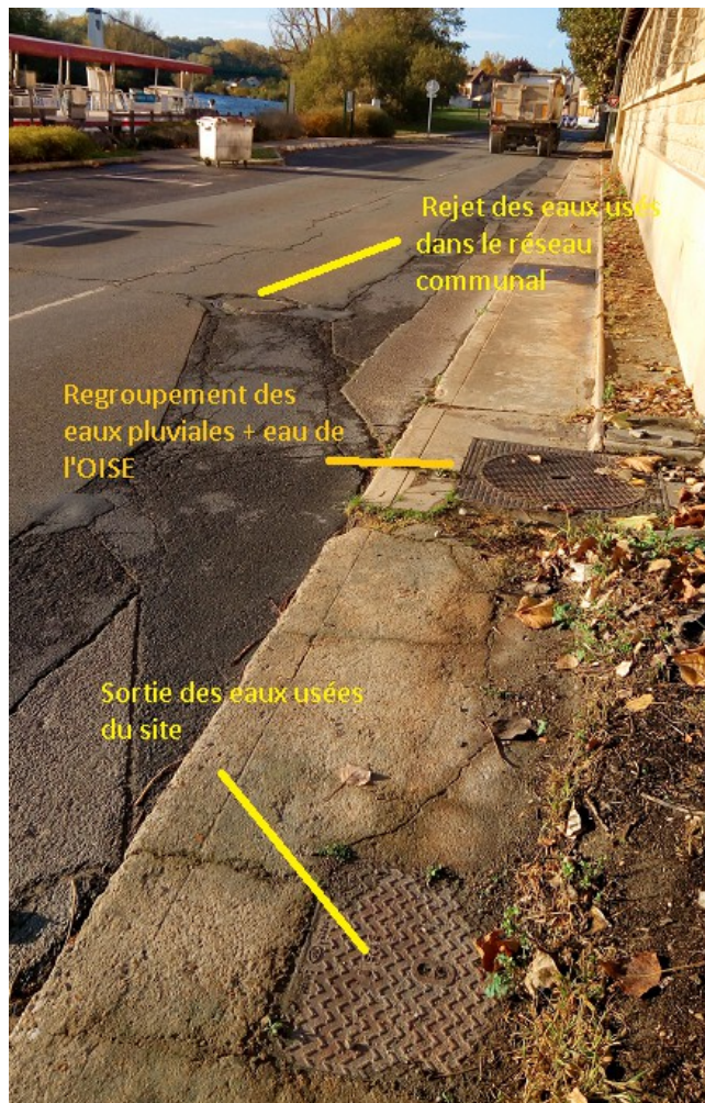
Photo 6 – Points de rejet des eaux pluviales et usées du site.
