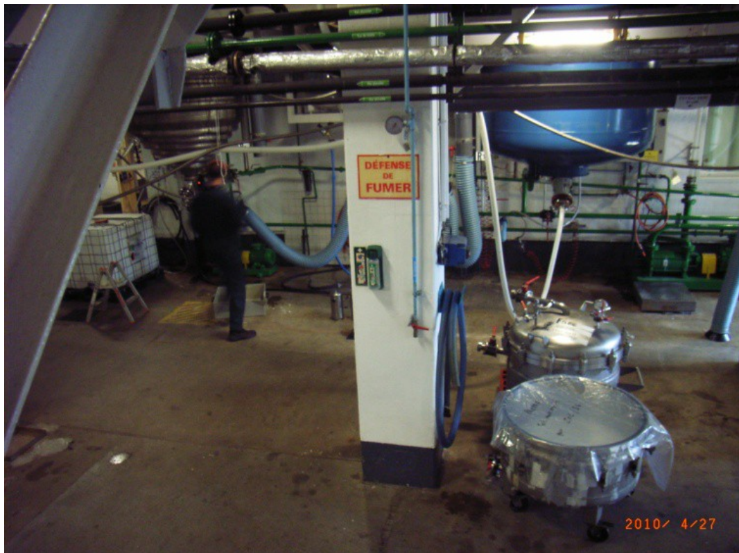
Photo 21 - RDC de l'atelier fabrication
